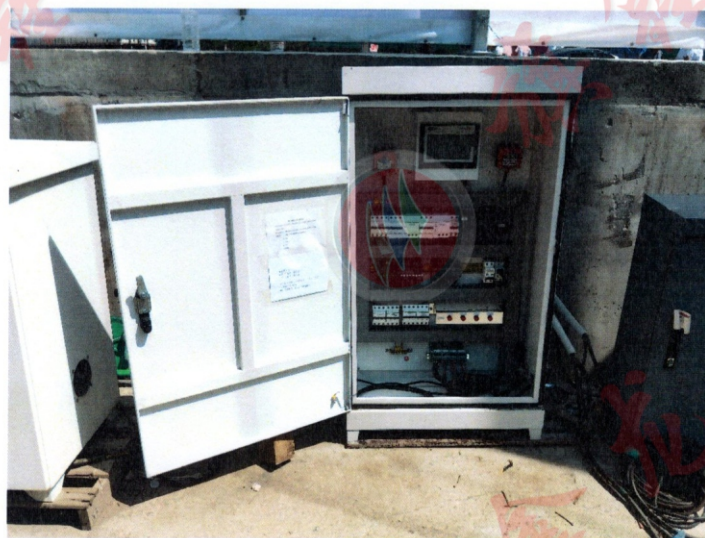
图二：LZYZ-B3-QXL01 型防暴升降式阻车路障控制系统外观状态
